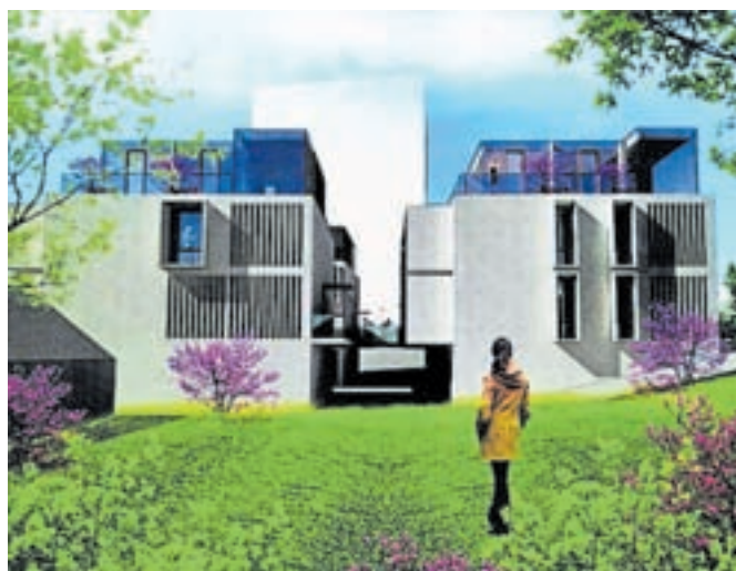
Objekti bodo zgrajeni po načelu pasivne nadstandardne gradnje.
