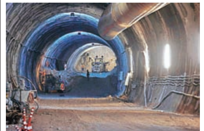
Polovica slovenskega dela druge cevi predora Karavanke je izvrtana. / FOTO: GORAZD KAVČIČ
