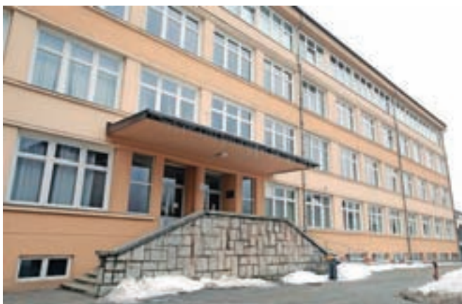
Srednja šola Jesenice že dolgo čaka na prenovo. Šolska stavba je bila zgrajena leta 1949 in nadzidana leta 1978, jo pa ves čas obnavljajo. / FOTO: GORAZD KAVČIČ
