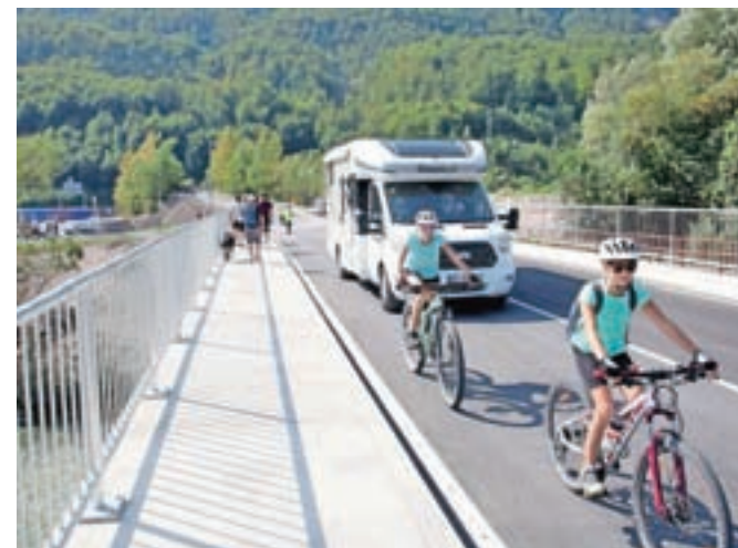
Novi most so zgradili ob starem in ga pred dnevi že odprli za promet. Stari most bodo podrli. / FOTO: GORAZD KAVČIČ
