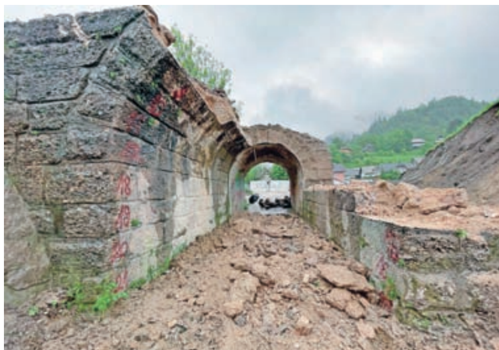
Razstavljanje kamnitih blokov / Foto: P. A.
