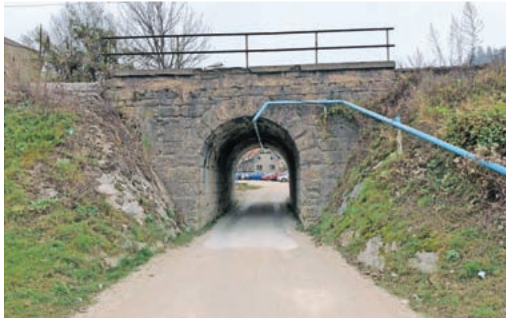
Podhod je bil zgrajen leta 1870 hkrati z železniško progo. / Foto: R. H.
