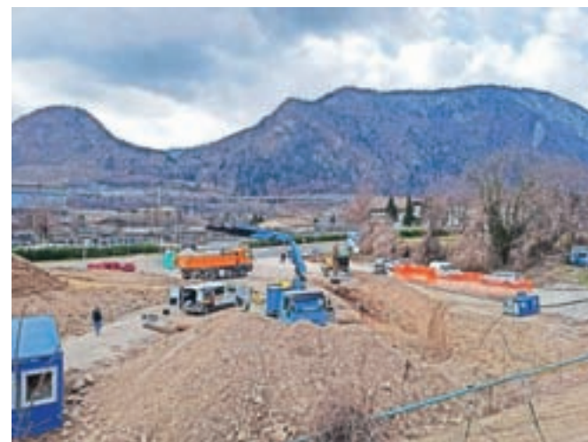
Gradnja dovozne ceste med obrati Acronija na Koroški Beli in Predelavo debele pločevine na Slovenskem Javorniku.
