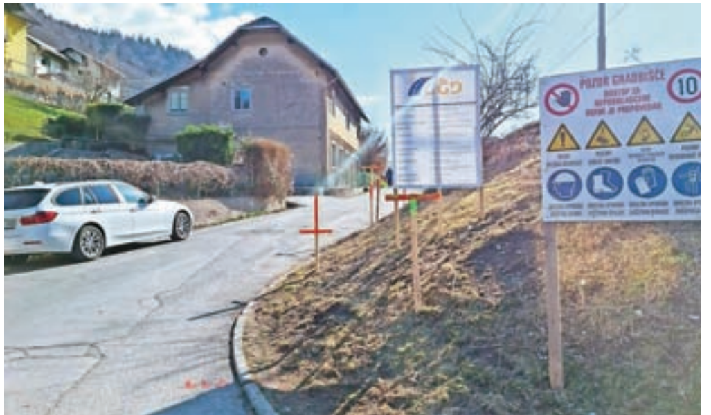
Na Cesti bratov Stražišarjev se je začela obnova kanalizacije.
