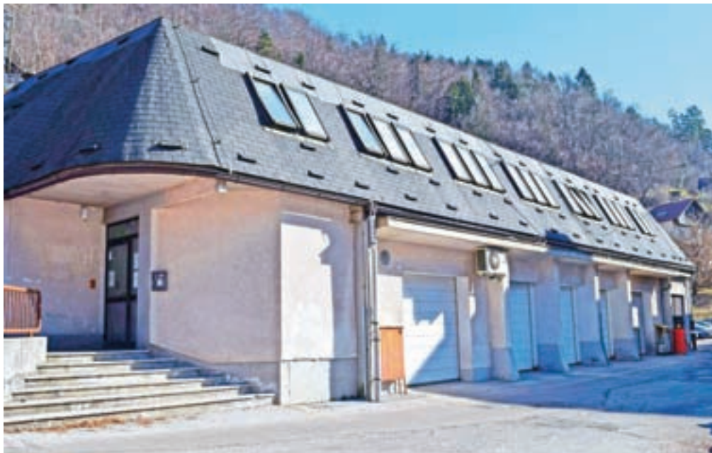
Stavbo na Titovi 78a ob jeseniškem zdravstvenem domu bodo obnovili in v celoti namenili zdravstveni dejavnosti. V spodnji etaži so že zdaj garaže za vozila nujne medicinske pomoči.
