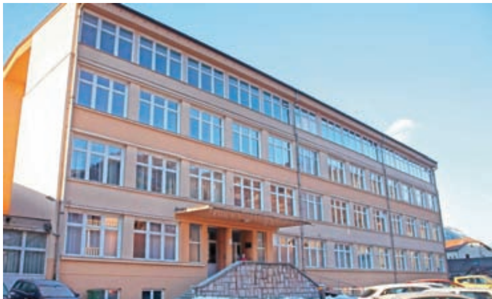
V zadnjem letu in pol so zamenjali streho na stavbi šole, obnovili najbolj načete dele fasade in del strehe na delavnicah. / Foto: Gorazd Kavčič
