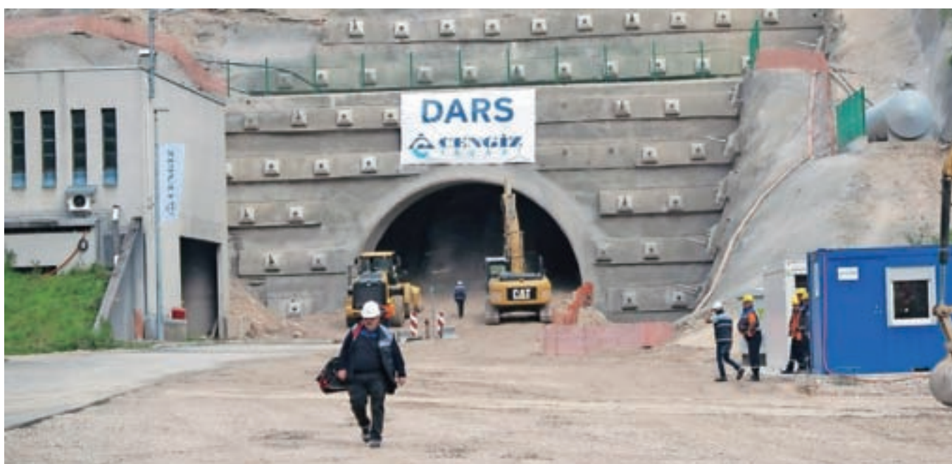
Izkopavati so začeli v zgornji polovici predorske cevi, tako imenovani kaloti predora.
