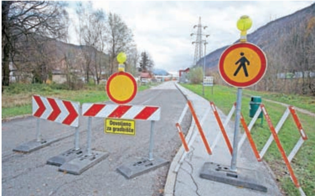
V sklopu del bodo obnovili cesto in pločnik ter vodovod in odvodnjavanje. / FOTO: GORAZD KAVČIČ
