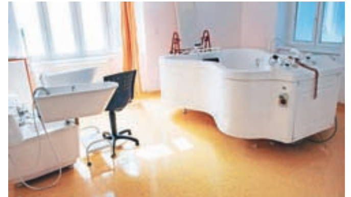
V sklopu del so prenovili tla, električno napeljavo, poskrbeli za požarno varnost.
