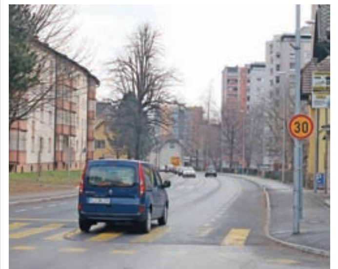
Obnovitvena dela so v večini zaključena, razen novega mostu. Odsek je zato še vedno gradbišče in velja omejitev hitrosti trideset kilometrov na uro. / FOTO: GORAZD KAVČIČ
