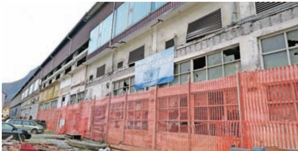
Stavba nekdanje lužilnice kislin bo postala sodoben poslovni objekt, v njem bo tudi interni učni center za kovinarje.
