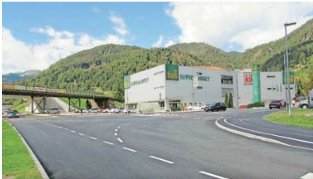
Obnovljeno križišče pri trgovini TUŠ
