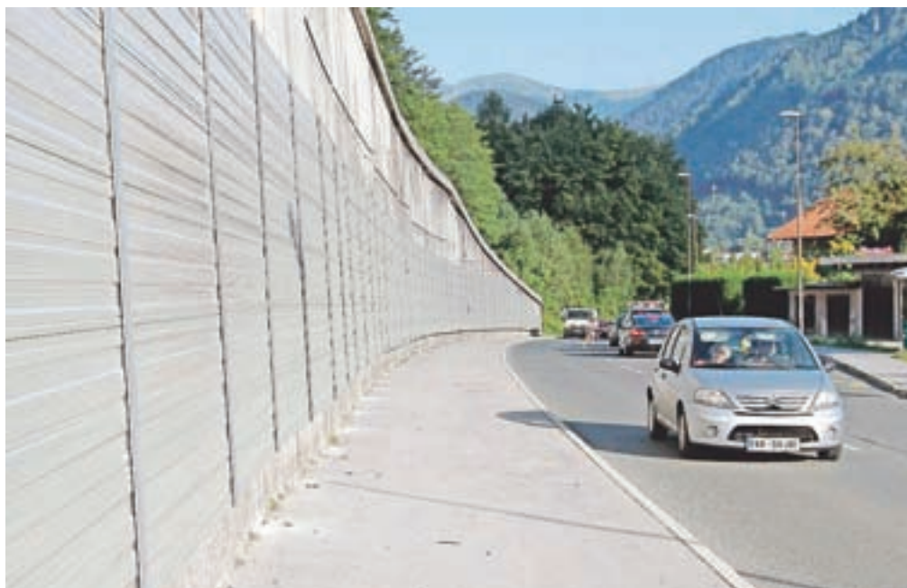
Država je vendarle uredila protihrupno zaščito na opornem zidu pri naselju Lipce. Od betonskega zidu se je namreč hrup prometa odbijal in se še okrepil. / FOTO: GORAZD KAVČIČ
