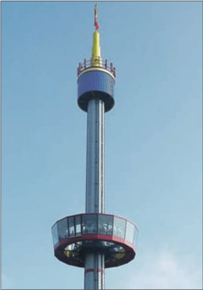
Celoten park je na ogled tudi z opazovalnega stolpa.
