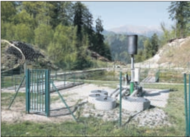
Na bakli (letos jo bodo zamenjali z novo) sežigajo deponijski plin, pripravljeni pa so že projekti izrabe plina.
