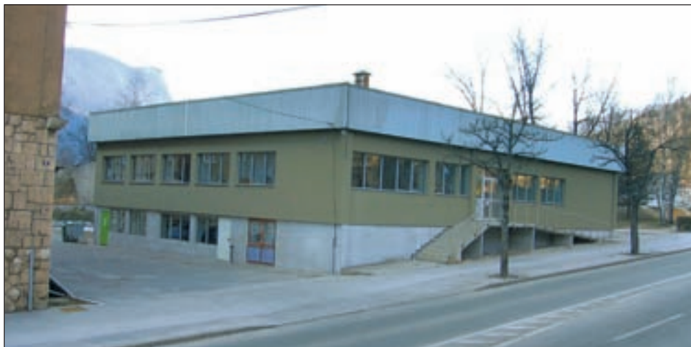
Lani so se lotili obnove stavbe zbornice. Poskrbeli so za izolacijo in novo zunanjo podobo stavbe ter izvedli več vzdrževalnih del.
