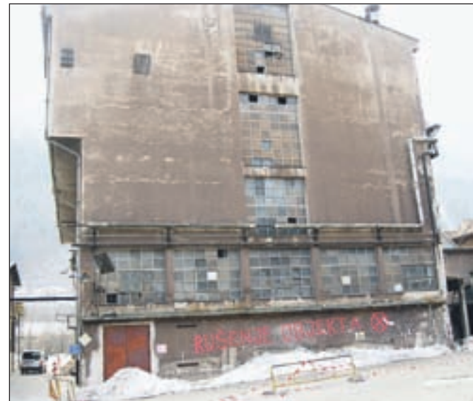
Staro kotlovnico so že začeli rušiti. FOTO: JANEZ PIPAN
