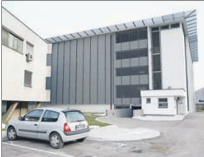
Na strehi garažne hiše je heliport, ki še vedno ostaja zaprt zaradi težav s projektiranjem požarnega sistema.
