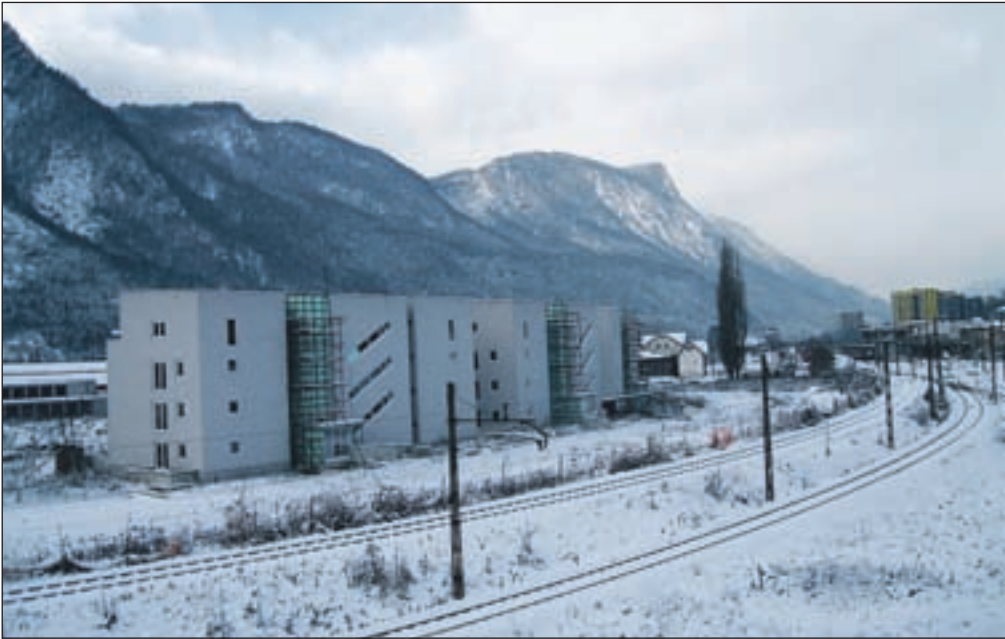
Aleasing zagotavlja, da bo dokončal gradnjo blokov v Hrenovci. | FOTO: JANEZ PIPAN
