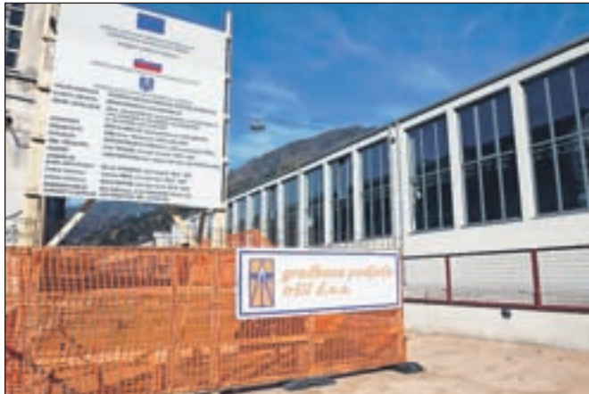
Eden večjih projektov v letu 2011 bo gradnja tržnice in ostala dela v sklopu projekta Celostna obnova urbanega središča Stara Sava. | Foto: ANKA BULOVEC
