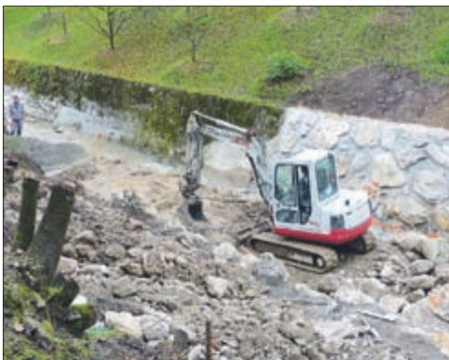
Vodnogospodarsko podjetje Kranj ureja zaplavno pregrado potoka Bela na Koroški Beli.
