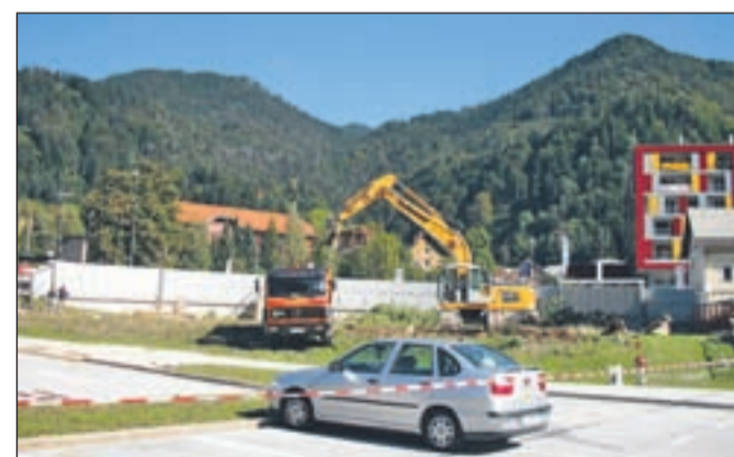
Upravni center Jesenice gradijo na mestu nekdanje kadrovske službe.
