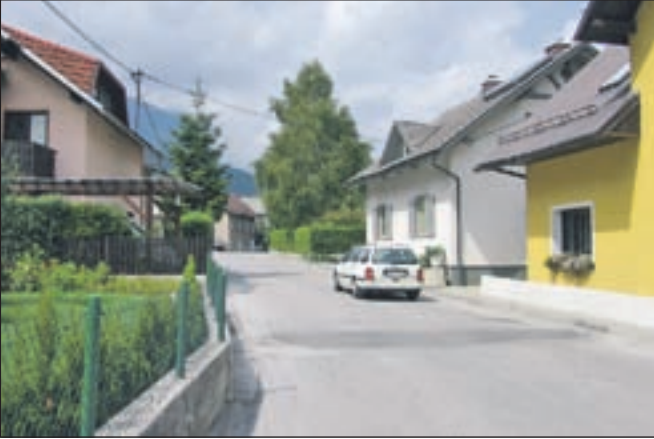
Ceste v KS Podmežakla čakajo na obnovo.
