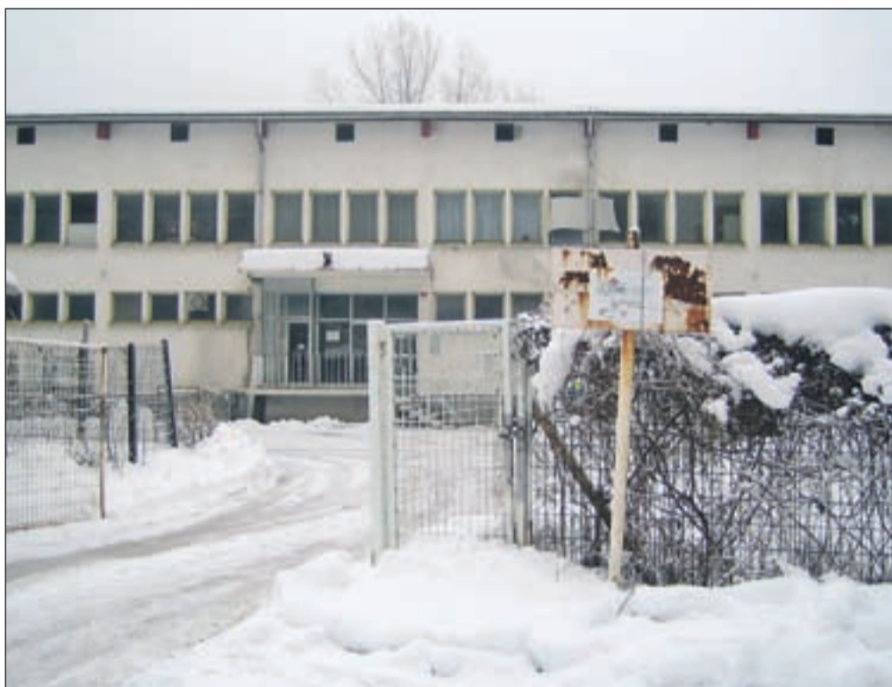
V stavbi nekdanje klavnice na Spodnjem Plavžu že urejajo prostore za začetek predelave odpadnih nagrobnih sveč.
