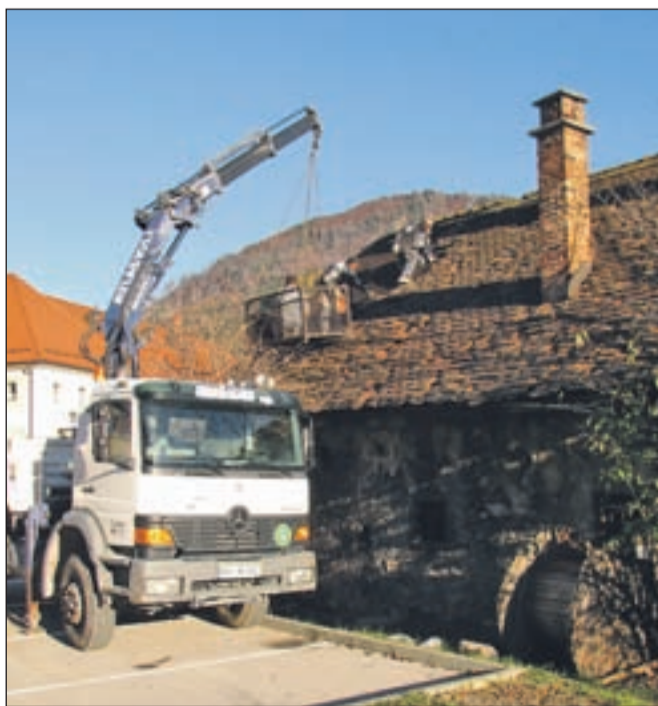
Ročno odstranjevanje strešnikov in odvoz na deponijo - priprave za rekonstrukcijo Korenove hiše. I FOTO: ARHIV DESIGN DAMJAN
