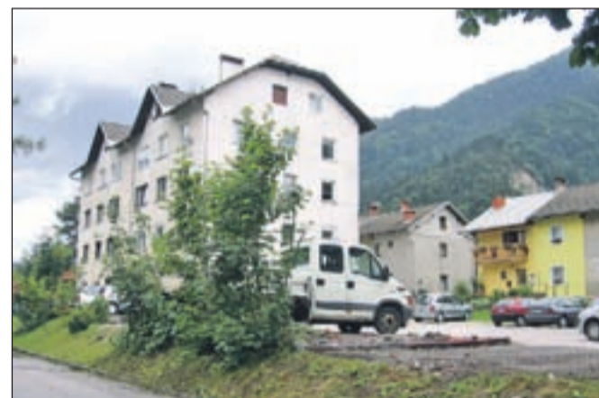
Na območju Republika 2 so skupaj s stanovalci odstranili črne gradnje, predvsem barake in garaže.
