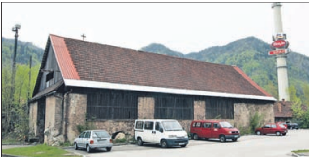
Kolperna na Stari Savi je bila nekdanje skladišče oglja. Z obnovo bodo ohranili njeno avtentičnost, hkrati pa ji bodo vdahnili novo življenje. I FOTO: ANKA BULOVEC
