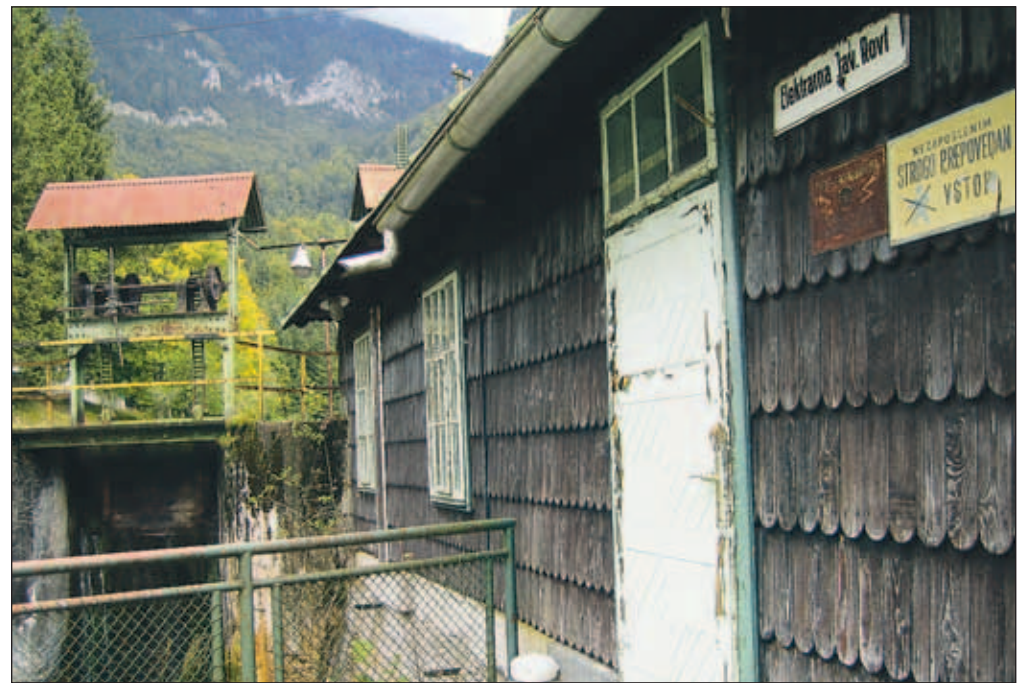
Hidroelektrarna Javorniški Rovt iz leta 1908 od zunaj ...
