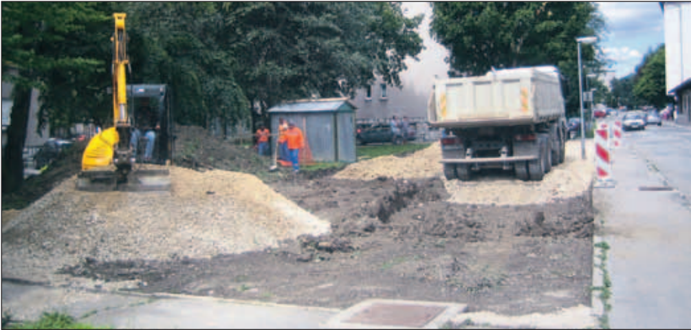
V prvih šolskih dneh velja večja previdnost na Tavčarjevi cesti in Cesti revolucije, kjer potekajo gradbena dela.
