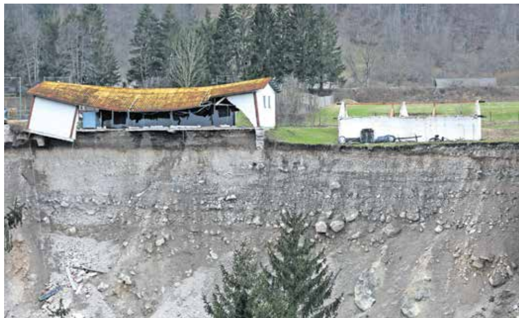
Izvajalec je do zdaj odstranil vse notranje regale v skladišču, kritino na manjšem objektu in polovico kritine na večjem objektu. / Foto: Gorazd Kavčič
