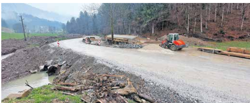
Gradnja novega mostu v Podobenem, kjer promet še vedno poteka po začasnih premostitvah / Foto: arhiv občine
