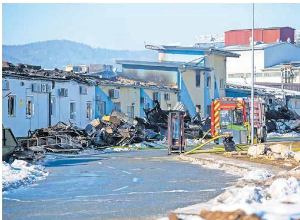
Petkov požar v industrijski coni na Trati v Škofji Loki je za seboj pustil veliko razdejanje. Oškodovanih je več podjetij. / Foto: Primož Pičulin
