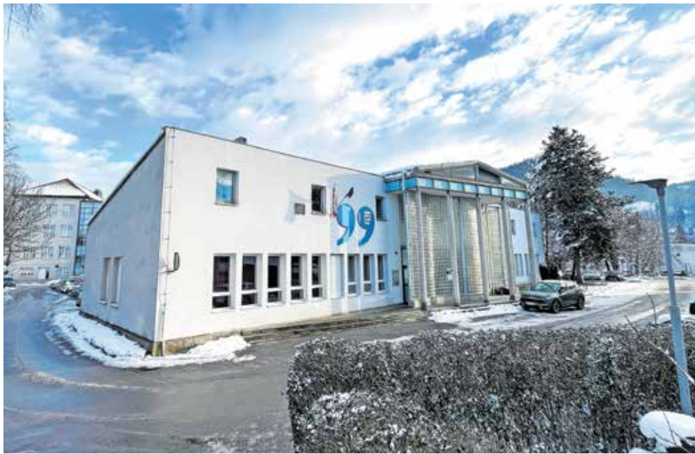
Knjižnica Franceta Balantiča Kamnik bo dobila dodatne prostore, objekt pa bo energetska saniran. / Foto: Aleš Senožetnik
