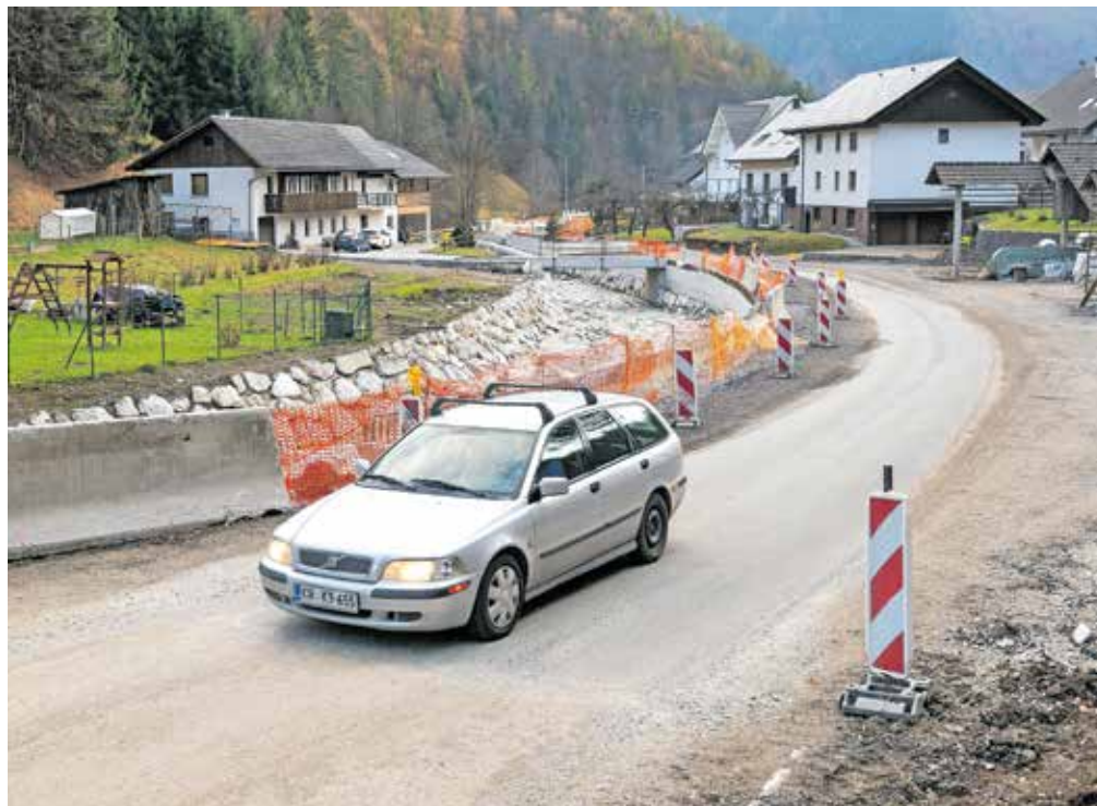
Kot so navedli na DRSI, določenih gradbenih del v zimskem času zaradi nizkih temperatur ni mogoče izvesti skladno s pravili stroke. / Foto: Simon Benedičič
