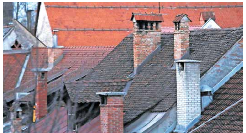
Omejitev za lesno biomaso bo veljala le, če se za to odloči občina, in le za nove ali prenovljene eno- ali dvostanovanjske stavbe v gosto naseljenih območjih, kjer je problematična kakovost zraka. Fotografija je simbolična. / Foto: Gorazd Kavčič
