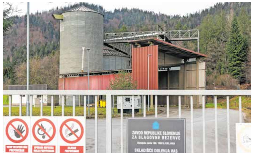
Silose v Dolenji vasi so zgradili v 80. letih prejšnjega stoletja in so zaradi dotrajanosti potrebni obnove. / Foto: Simon Benedičič
