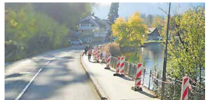
Občina Bled bo 8. januarja začela gradnjo novega konzolnega pločnika na Mlinem.
