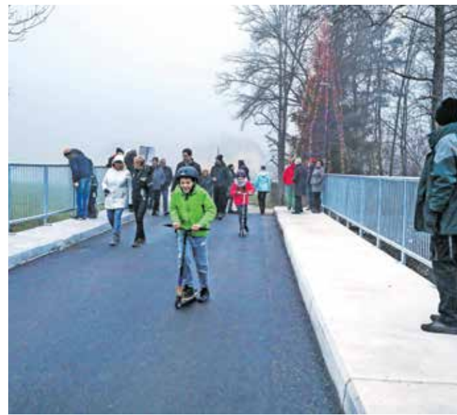
Ob odprtju obnovljenega mostu čez Kokro / Foto: Tina Dokl
