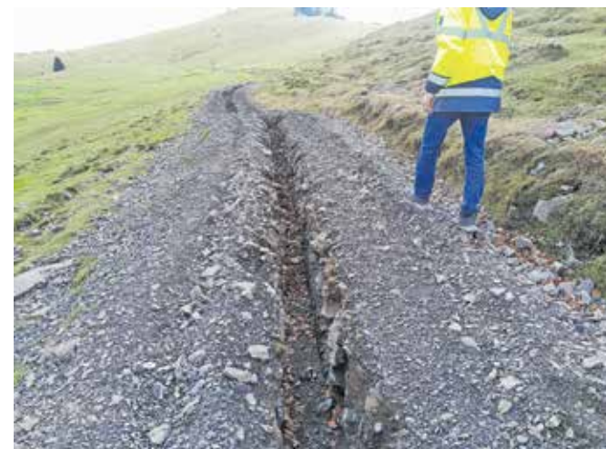
Gradnja kablovoda večinoma poteka po planinskih poteh.
