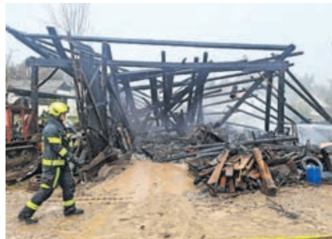
Zgorelo je vse, škoda je velika. / Foto: GARS Kranj
