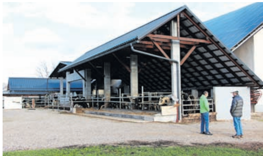
Stari hlev so preuredili, ob njem pa zgradili potrebne objekte.
