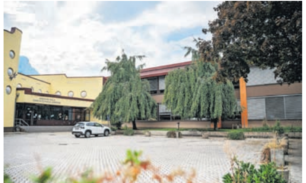
Novo streho na Osnovni šoli Toneta Čufarja je naposled dokončalo podjetje Streha Kuhar. Sodišče je zaslišalo tudi njegovega direktorja Staneta Kuharja. / Foto: Nik Bertonec
