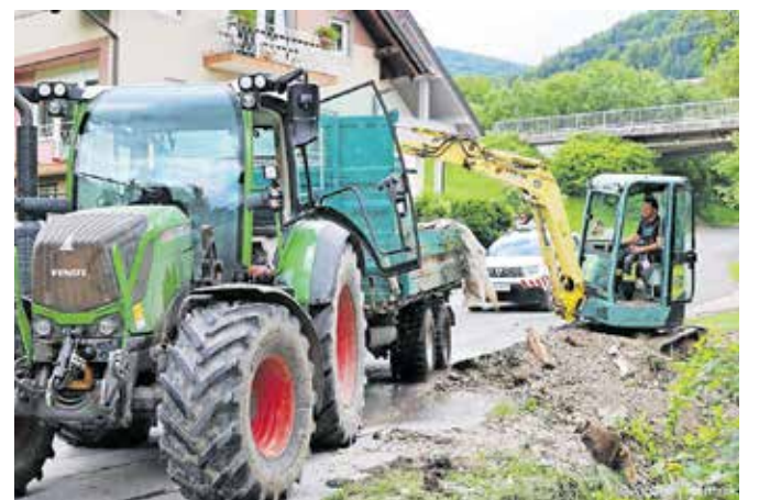
V Motniku so takoj po junijskem neurju začeli izvajati interventna dela (na fotografiji), na dokončno sanacijo pa še čakajo. / Foto: arhiv CG/Občina Kamnik
