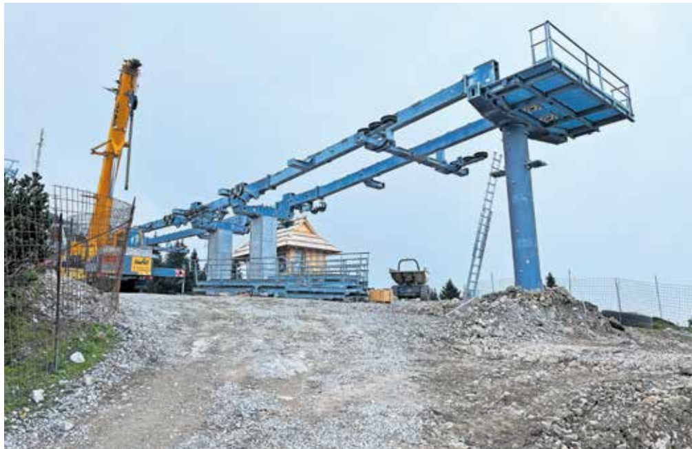
Takole je bila videti gradnja šestsedežnice sredi septembra. Zdaj potekajo zaključna dela.
