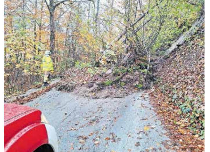
V nedeljo sta zemeljska plazova zasula cesti do naselij Ravne in Nemški Rovt na območju občine Bohinj, a so ju pristojni še isti dan sanirali. / Foto: PGD Bohinjska Bistrica
