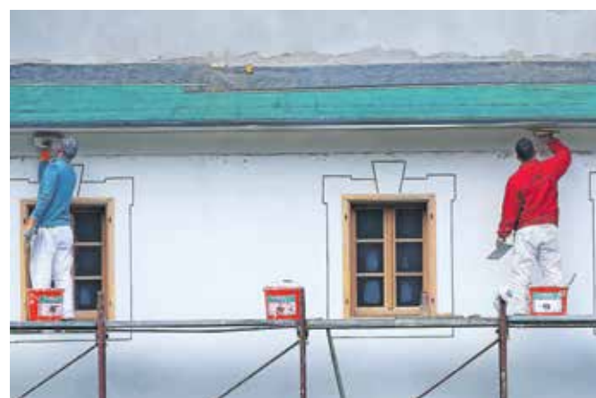
Za energetske sanacije so pri bankah na voljo tudi različna posojila. Fotografija je simbolična. / Foto: Gorazd Kavčič
