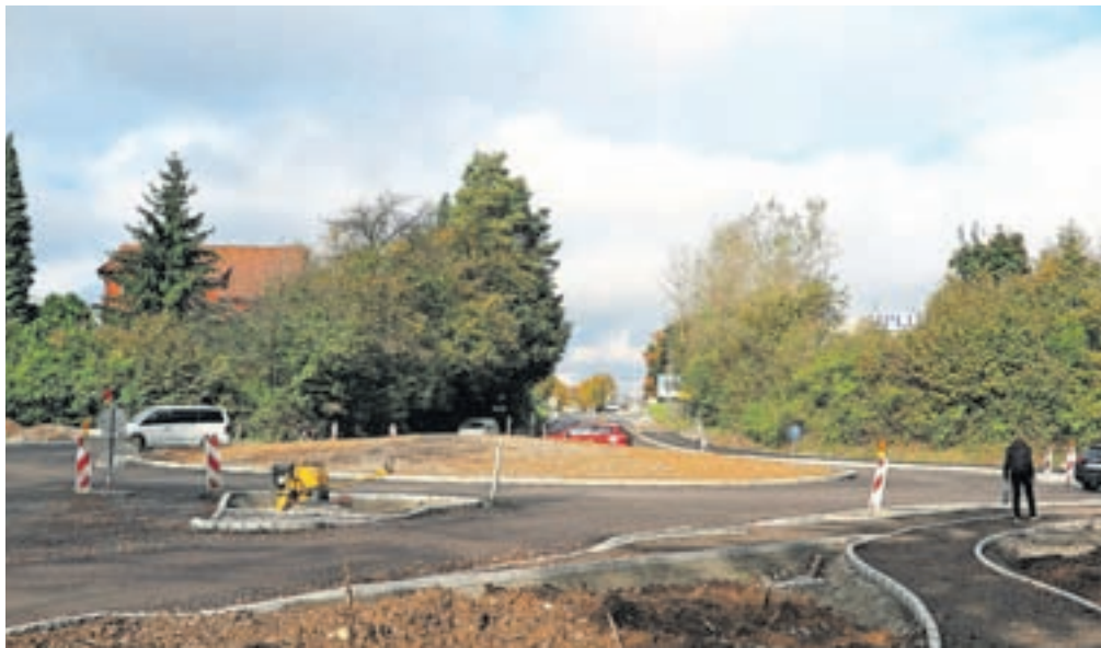
Krožišče Lipica že dobiva končno podobo, za praznike pa se bo moč peljati do parkirišča pri pokopališču. / Foto: Vilma Stanovnik
