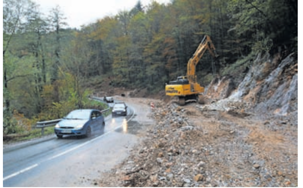
Po udaru cestišča v avgustovskih nalivih ta čas poteka rekonstrukcija dobrih 360 metrov dolgega odseka ceste Podlubnik–Praprotno. Dela naj bi potekala do konca novembra.
