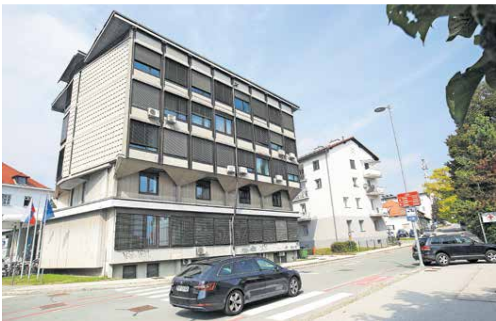
Kranjski sedež Ajpesa (bivši SDK), zgrajen v letih 1968–1970, zaznamuje večkotna tlorisna zasnova, ki se odraža tudi na fasadi. / Foto: Gorazd Kavčič
