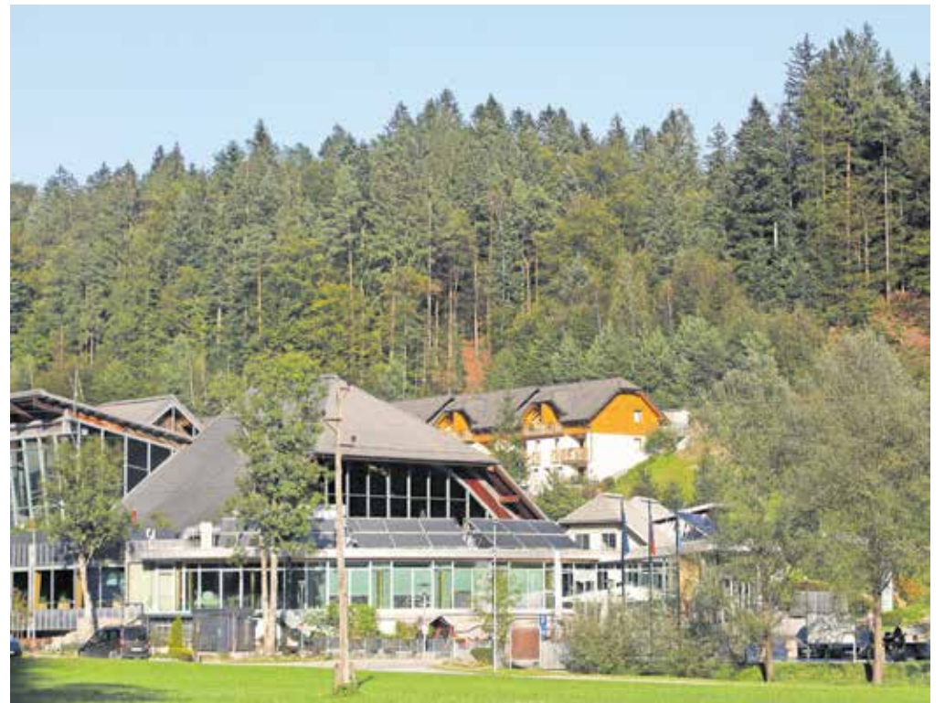
Gradnja hotela je predvidena pred apartmajskim naseljem. / Foto: Gorazd Kavčič
