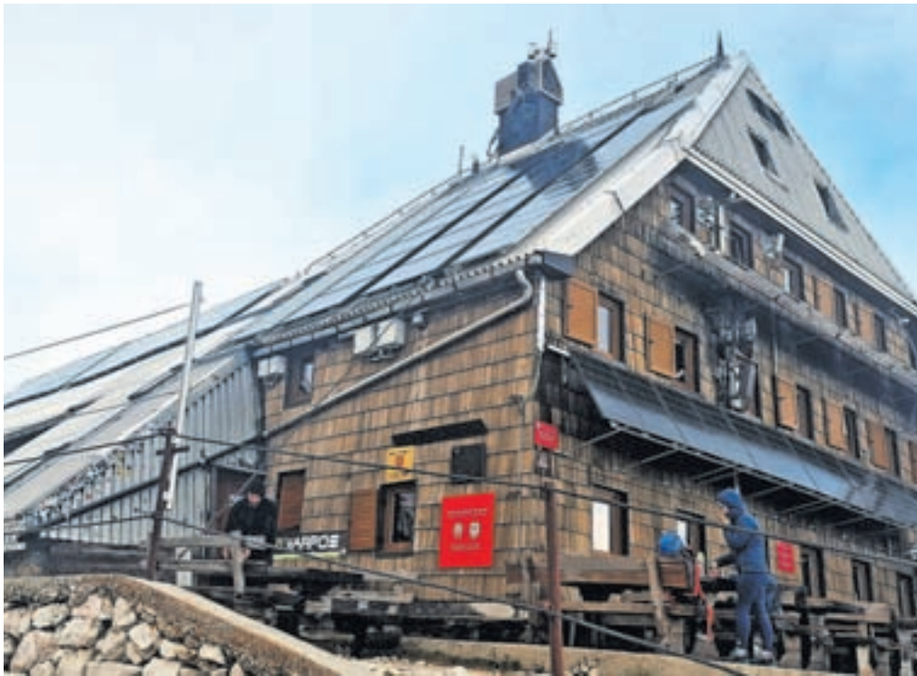
Zamenjali so več kot dvaindvajset let stare sončne celice, z novimi imajo za sto odstotkov več energije. / Foto: arhiv Triglavskega doma na Kredarici
