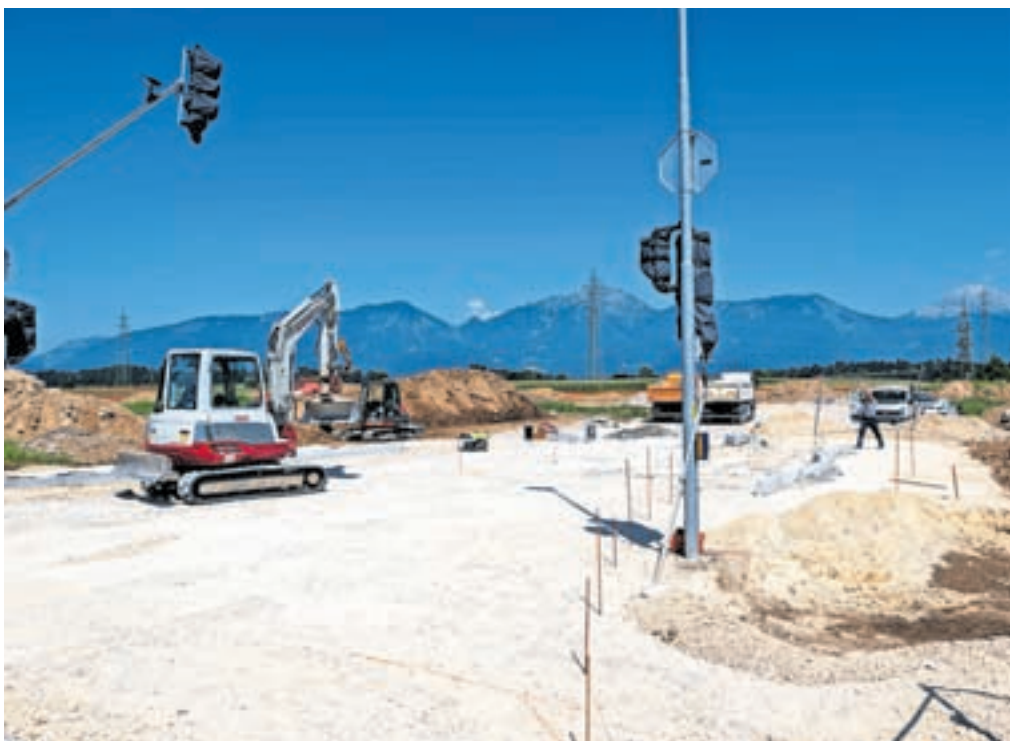
Trenutno gradijo cestno in komunalno infrastrukturo, stanovanja naj bi začeli graditi septembra. / Foto: Primož Pičulin
