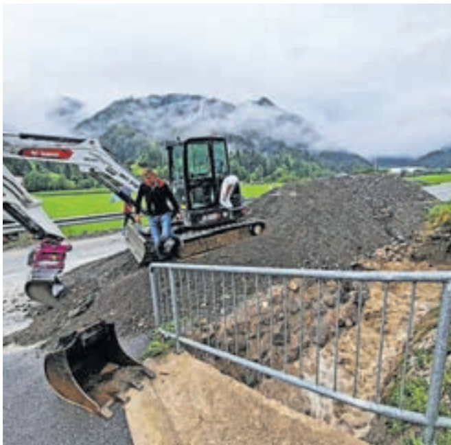
V občini Železniki so čistili in urejali hudournike.
