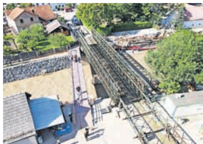
Gradnja nemškega montažnega mostu v Prevaljah
